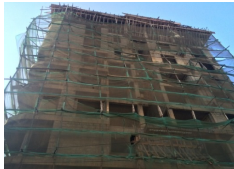
Baustelle: Gerüste in Arusha
