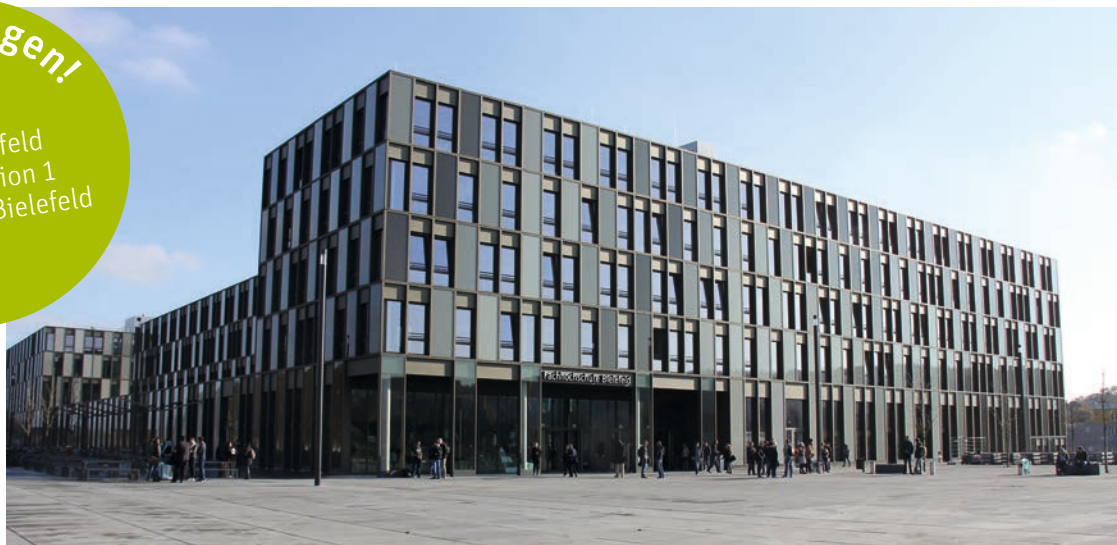
Die neue Anschrift im FH-Hauptgebäude (FHG):
