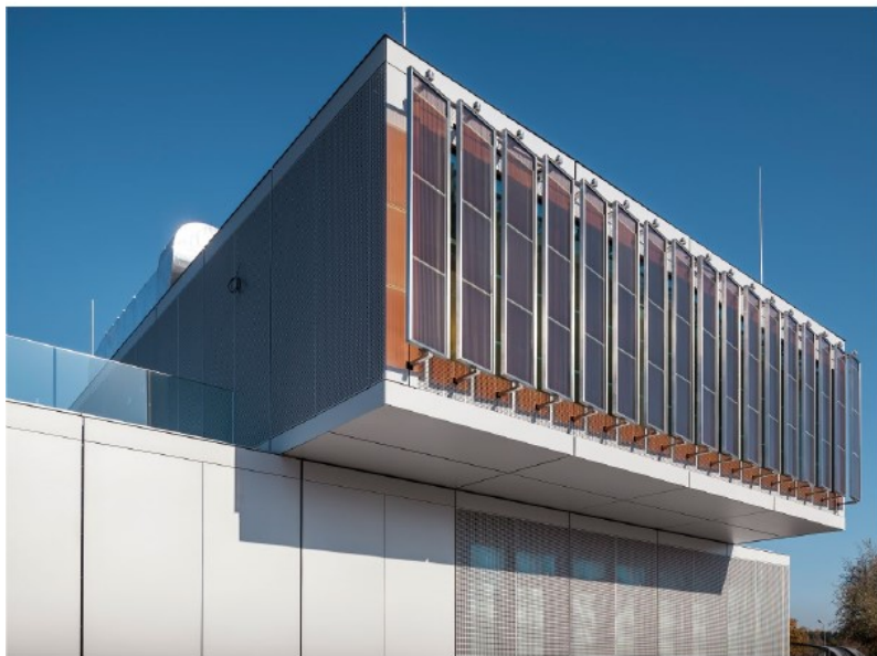
Drehbare Paneelen mit Farbstoffsolarzellen an der Fassade des Modularen Innovationszentrums der Firma Merck in Darmstadt (Foto: L. Gruber | Colt International).
